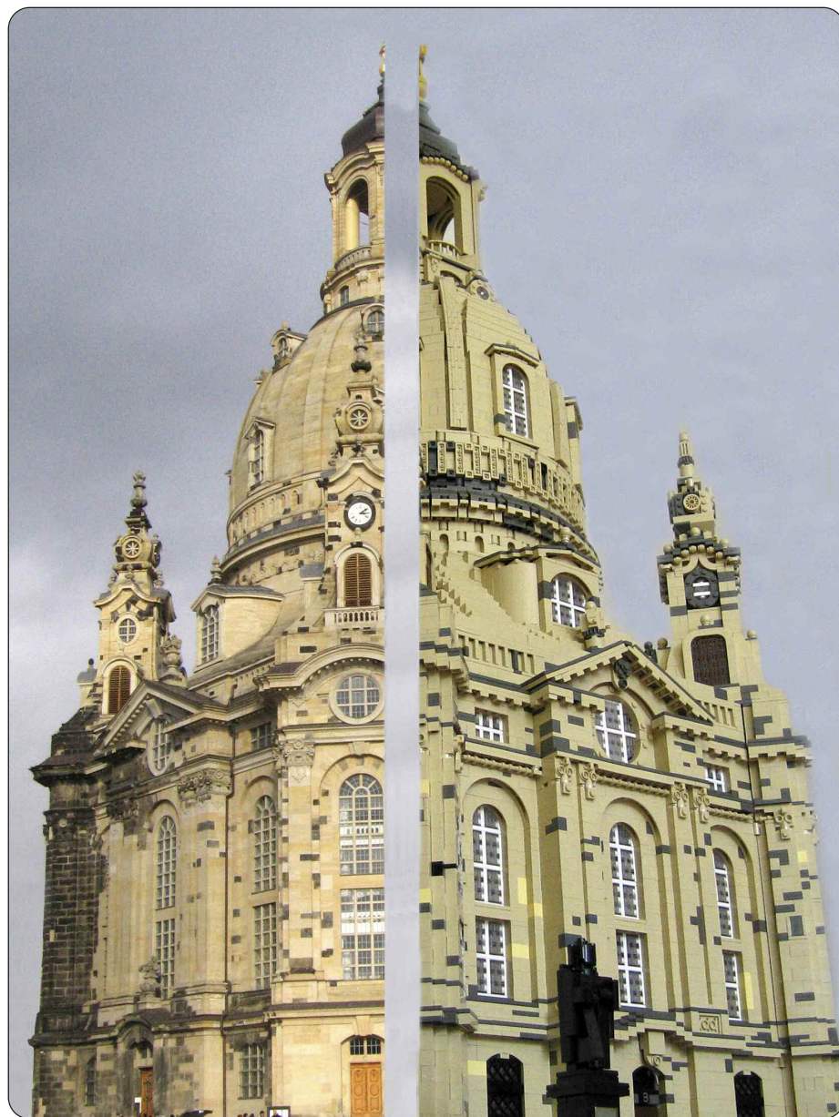
Der Wiederaufbau der Dresdener Frauenkirche geschah unter Verwendung des alten Baumaterials. Schmückt nun ein Original das Stadtbild oder eine Kopie?
